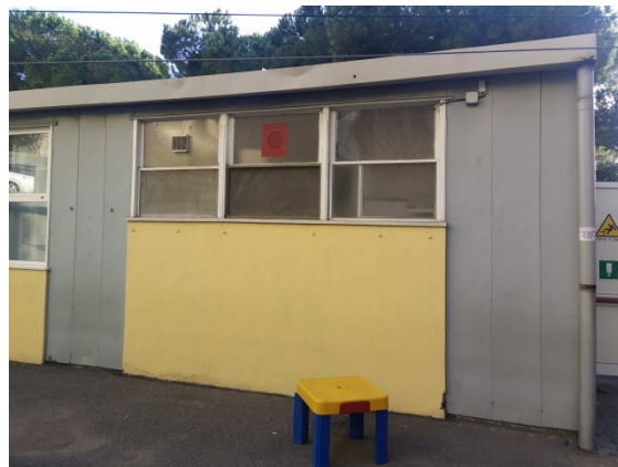
Figura 8.3 – Particolare della facciata da isolare esposta a nord ovest
