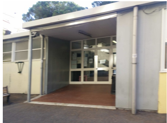
Figura 1.1 - Vista della facciata esposta a Nord
