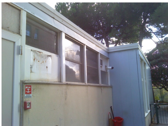
Figura 4.5 – Rilievo termografico dei serramenti
