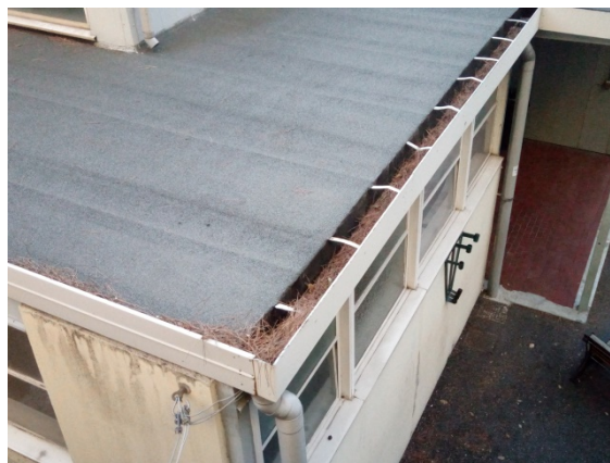
Figura 8.1 - Particolare copertura piana su cui intervenire.
